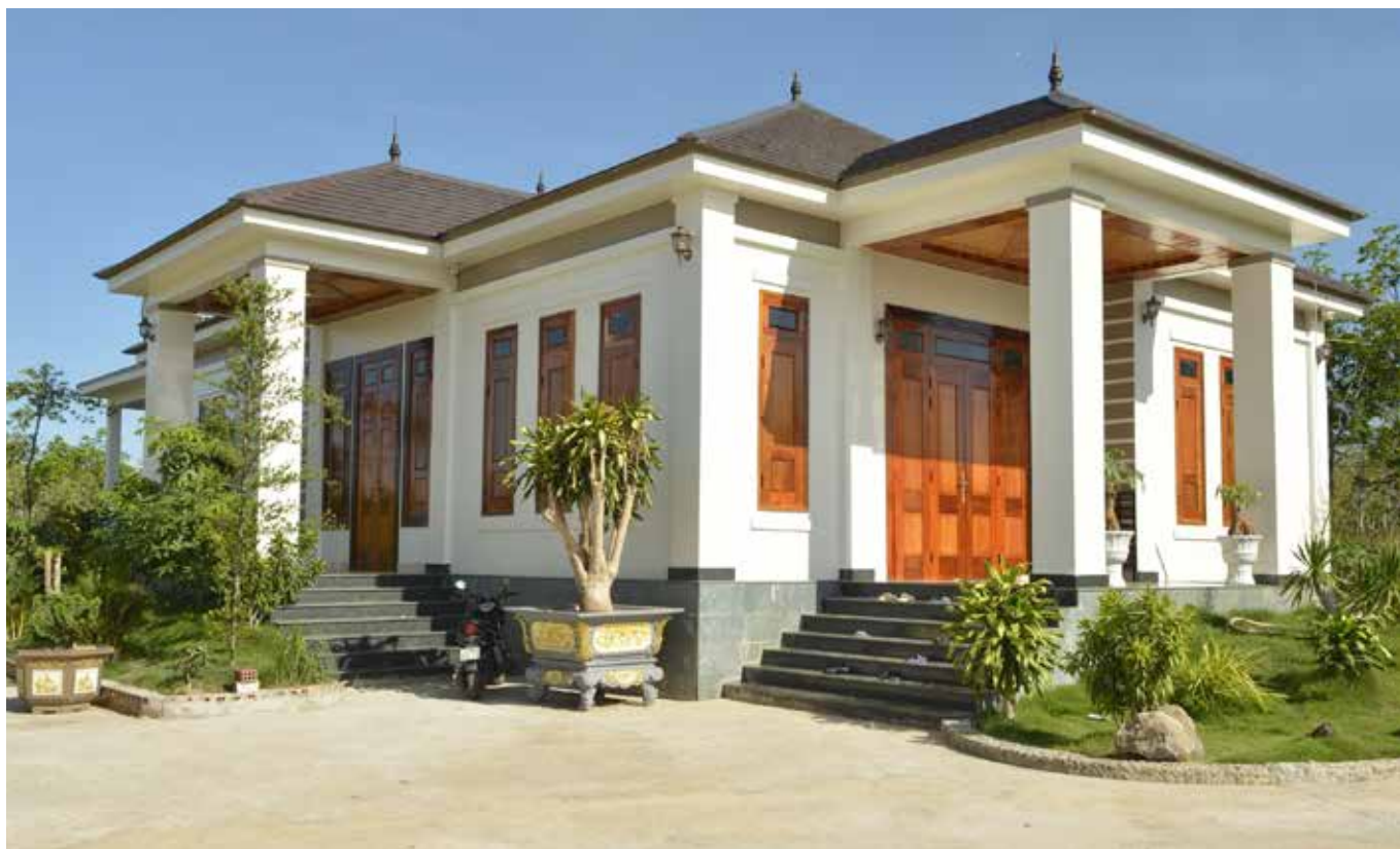
Công trình sử dụng ngói phẳng tại đường Phạm Hùng - Đà Nẵng
