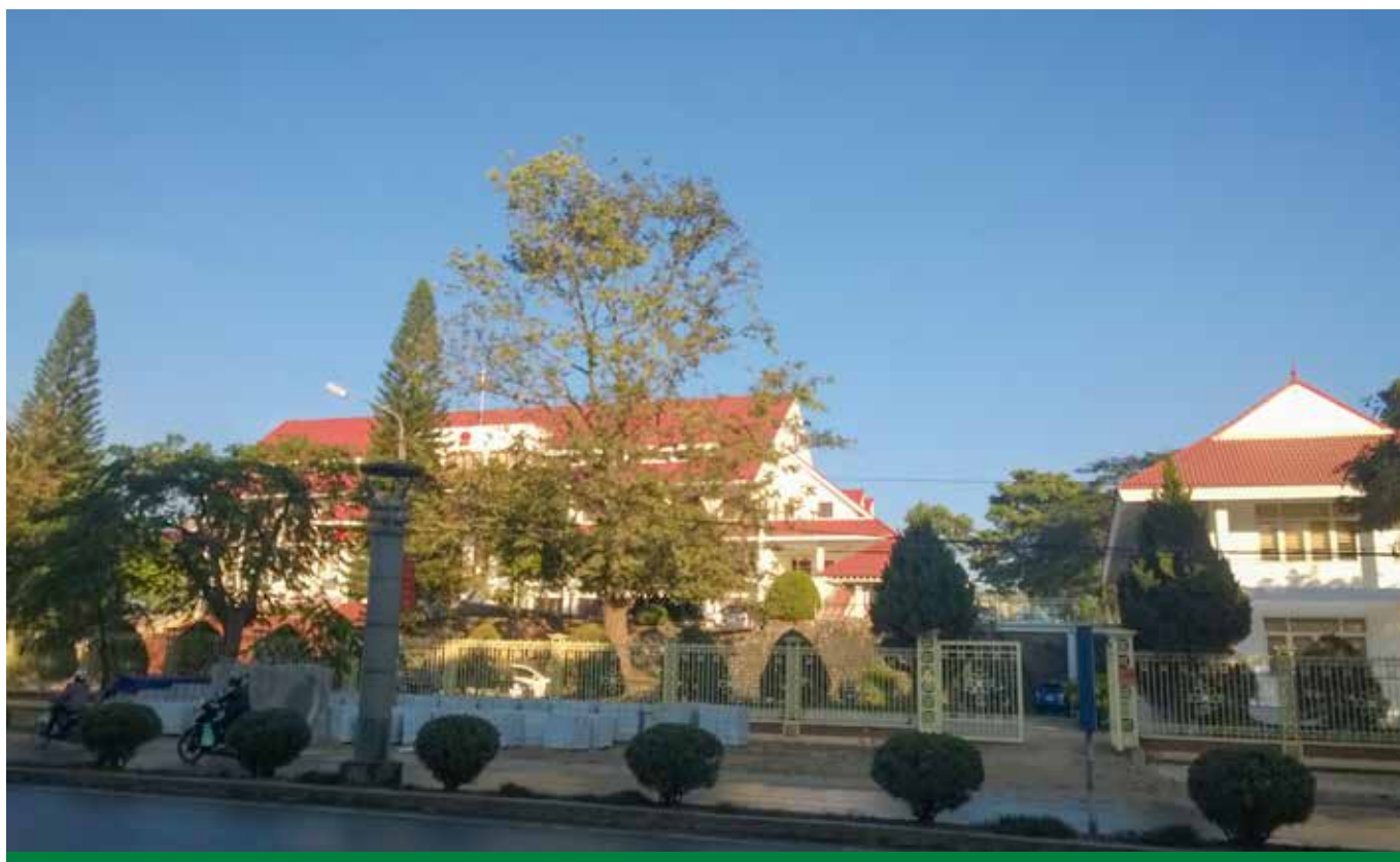
Dự án UBND Tỉnh Điện Biên
